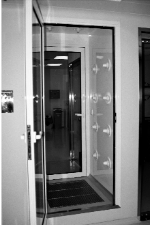
Fig. 3. Ducha de aire para el personal en el laboratorio de toxicología.
