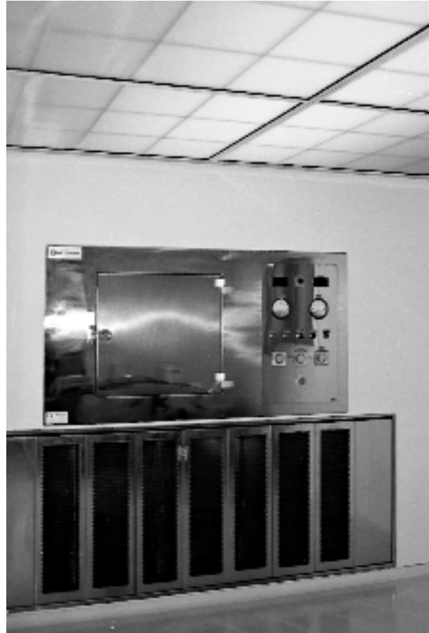
Fig. 2. Cabina libre de polvo con flujo direccionado en el techo.
